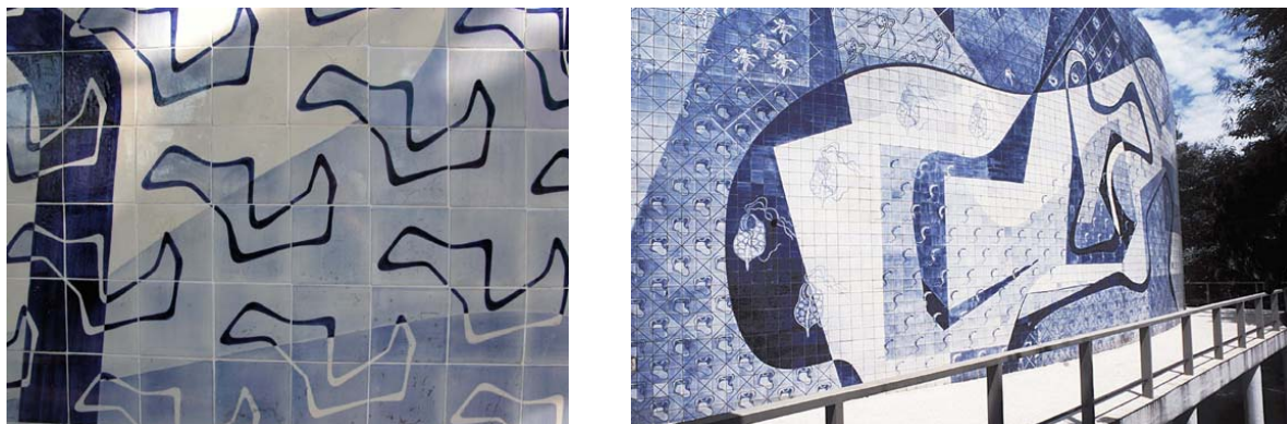
(Figura 3) Vista dos painéis modernistas. À esquerda o criado e executado por Paulo Osir Rossi para o Pavilhão de Cursos. À direita o de Burle Marx, também executado por Rossi, no Pavilhão de Cursos. Ambos foram recentemente restaurados pela equipe do DPH.
