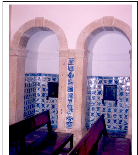
Figura 1. Revestimento de azulejos nas paredes dos confessionários
