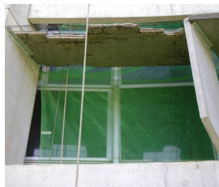
Figura 17: Pilar de fachada do edifício. Corrosão de armadura e destacamento de concreto. Foto: Ana Holanda
