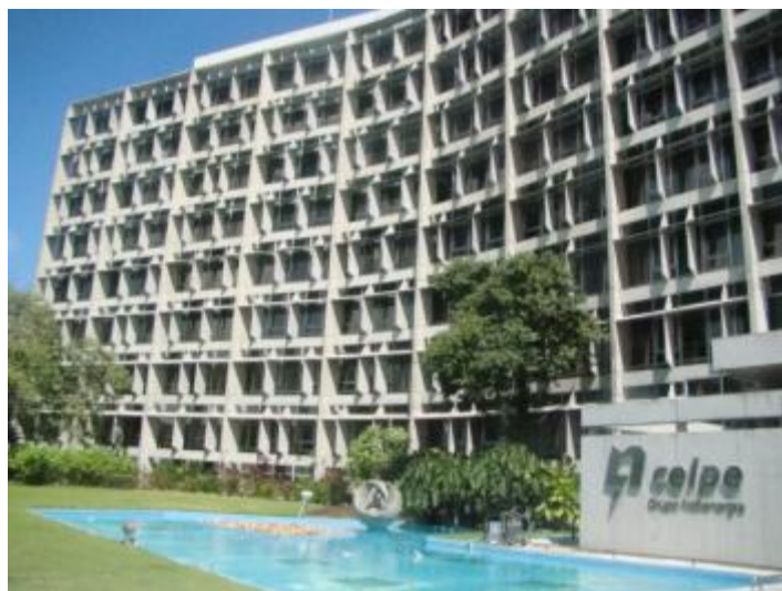
Figura 05: Sede da CELPE, Vital Pessôa de Melo e Reginaldo Esteves, 1975. Vista da fachada principal do edifício. Foto: Fernanda Herbster, 2012.
