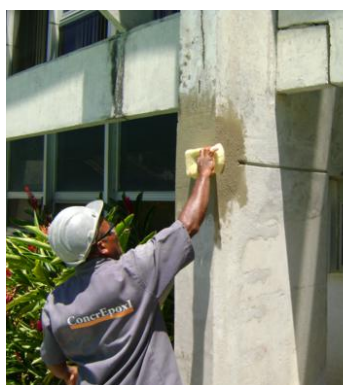
Figuras 20-22: Intervenções executadas no edifício da CELPE. Recuperação de pilares e brises, laje da entrada principal. Fotos: Concrepoxi, 2009.
