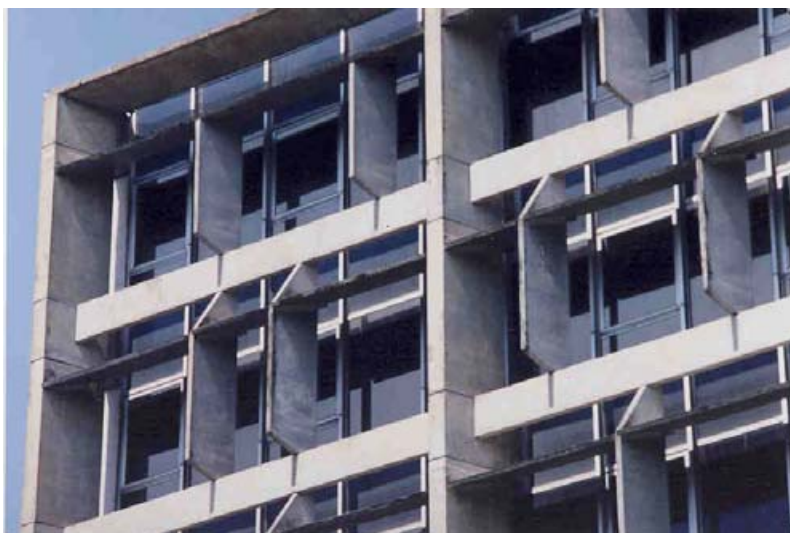
Figura 06: Detalhe da fachada frontal da CELPE. Brises verticais e horizontais. Foto: Ana Holanda, 2010.
