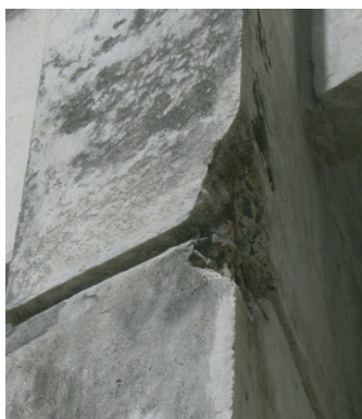
Figura 17: Pilar de fachada do edifício. Corrosão de armadura e destacamento de concreto. Foto: Ana Holanda
