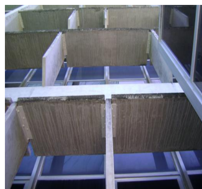
Figuras 20-22: Intervenções executadas no edifício da CELPE. Recuperação de pilares e brises, laje da entrada principal. Fotos: Concrepoxi, 2009.
