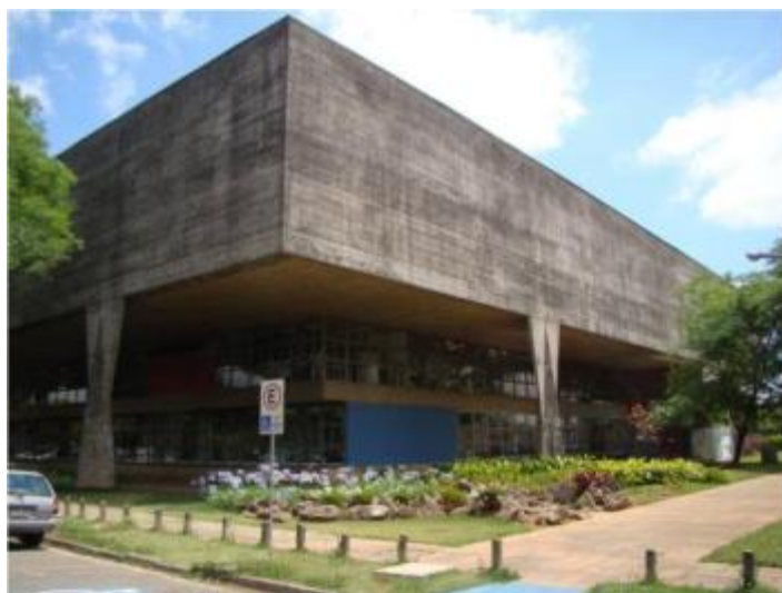
Figura 01: Edifício Vilanova Artigas, FAUUSP, São Paulo, SP. Vilanova Artigas e Carlos Cascaldi. Foto: Fernanda Herbster, 2011.
