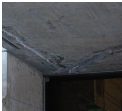
Figura 17: Pilar de fachada do edifício. Corrosão de armadura e destacamento de concreto. Foto: Ana Holanda
