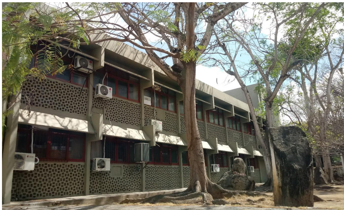
Figura 2: Bloco Administrativo CM. UFCG. Fonte: PEREIRA, Ivanilson. 2018.
