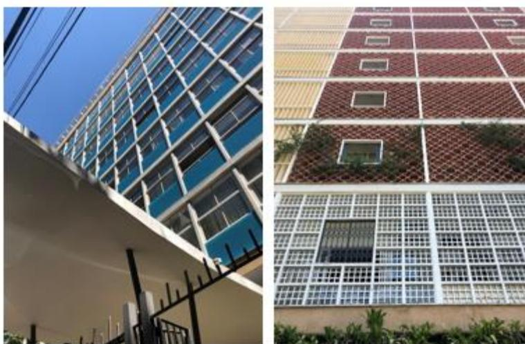
**Figura 2:** Face Sul em vidro e face Norte em elementos vazados.
