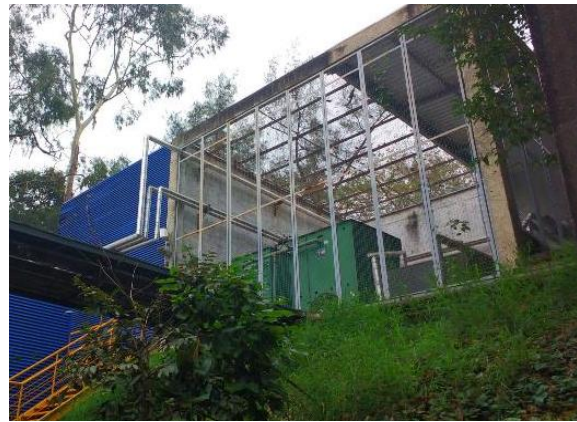
Figura 16 Laboratório da Febre Amarela: anexos construídos no entorno, 2016. Foto: Rosana Zouain
