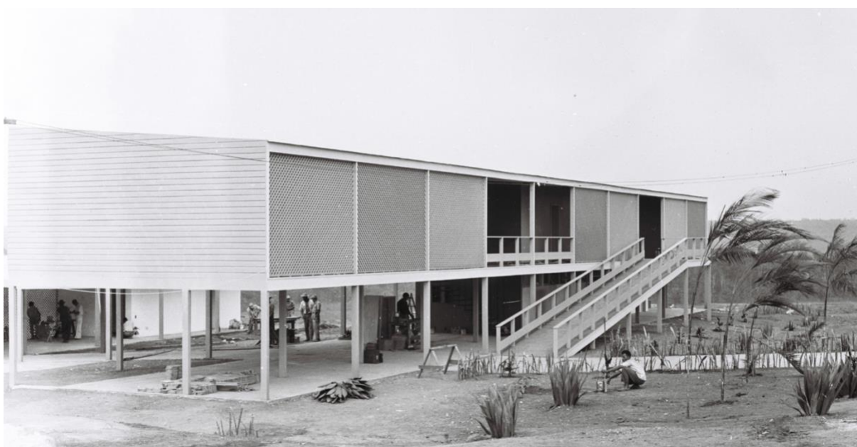
Figura 3: Fachada frontal da Escola Júlia Kubitschek. Fonte: IPHAN, 2017, p.37.
