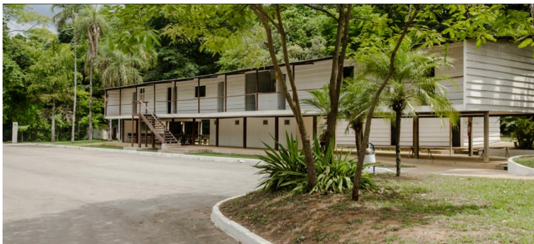
Figura 2: Fachada principal do Catetinho. Fonte: IPHAN, 2017, p.85.
