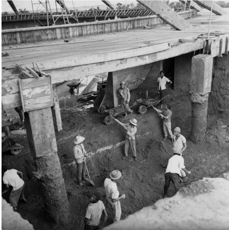
Figura 2: Operários trabalham na Catedral de Brasília em 1960. Fonte: Arquivo Público do Distrito Federal.
