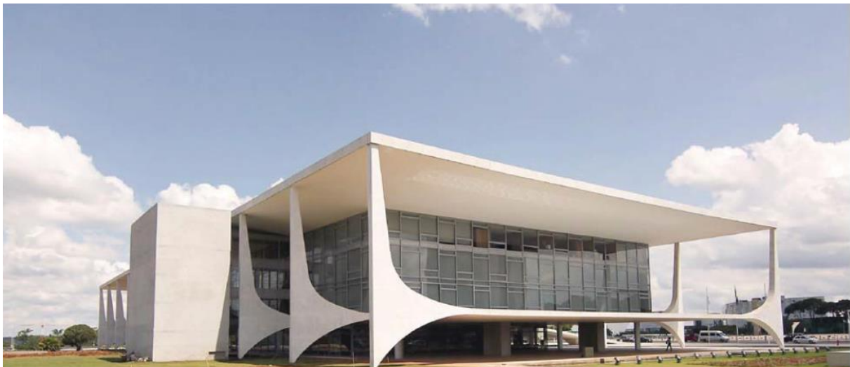
Figura 11: Inserção da torre externa anexa à fachada norte do Palácio do Planalto. Foto: Élcio Gomes (2011). Fonte: SILVA, 2012, p.551.
