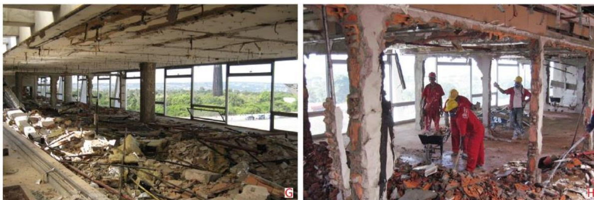
Figura 14: Demolição dos jardins internos do 4º pavimento: notar lajes do pergolado; supressão da alvenaria e revestimentos, com manutenção apenas de elementos estruturais. Fonte: PÁDUA, 2013, p.227.
