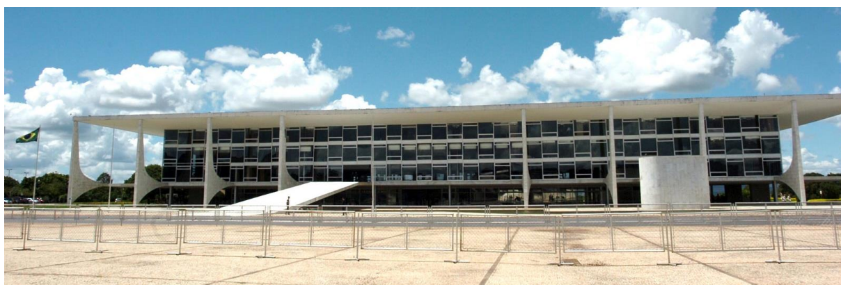
Figura 12: Fachada principal antes da obra de restauração. Fonte: Inventário, 2010, p.50.
