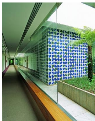
Figura 9: Azulejos antes da intervenção.
