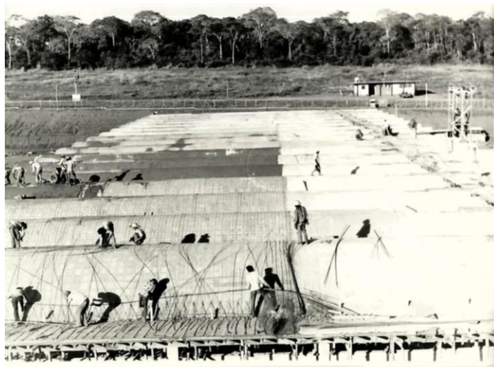
Figura 9: CEASA Goiânia: vista da execução das abóbadas autoportantes. Fonte: Cortesia de CEASA Goiânia
