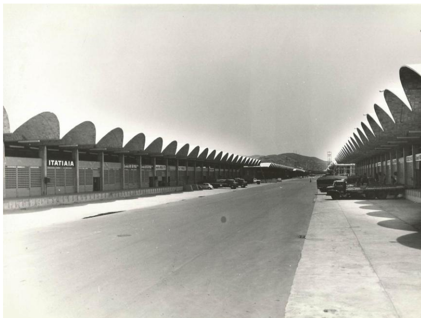
Figura 5: CEASA Rio de Janeiro: vista geral dos pavilhões em abóbadas autoportantes (década de 1970). Fonte: Cortesia de CEASA Rio de Janeiro
