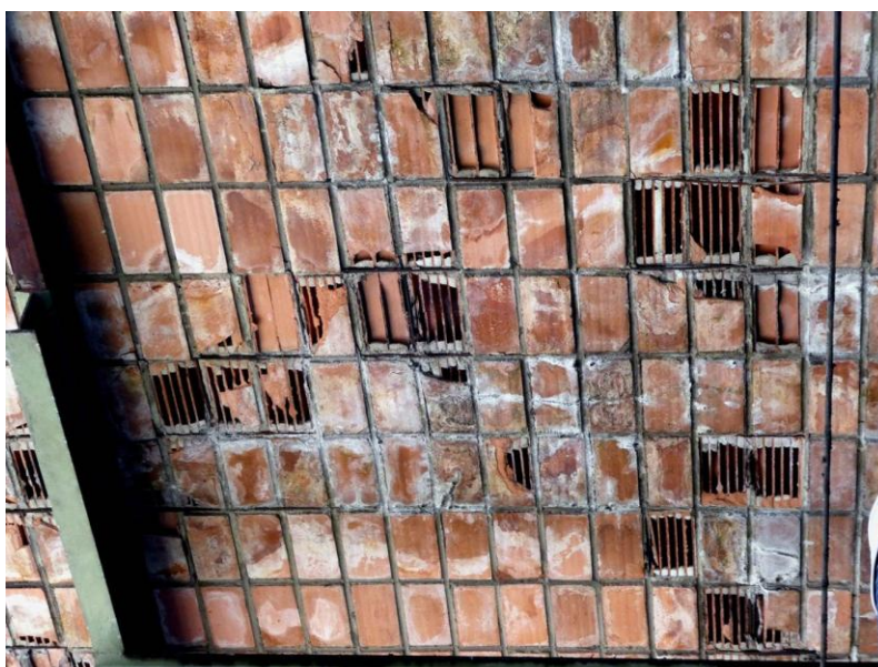
Figura 7: CEASA Rio de Janeiro: detalhe do estado atual dos tijolos da cobertura em abóbadas. Fonte: Autora, 2018
