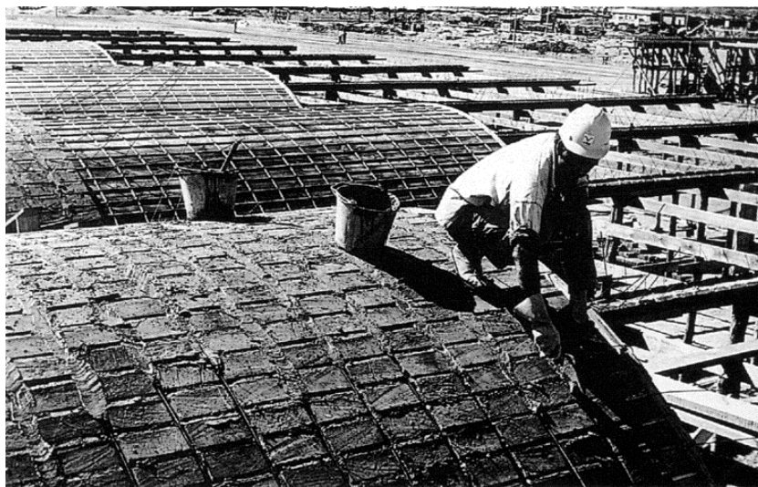
Figura 1: Execução de cobertura em cerâmica armada da CEASA Porto Alegre. Fonte: FITZ, 2015, p.35
