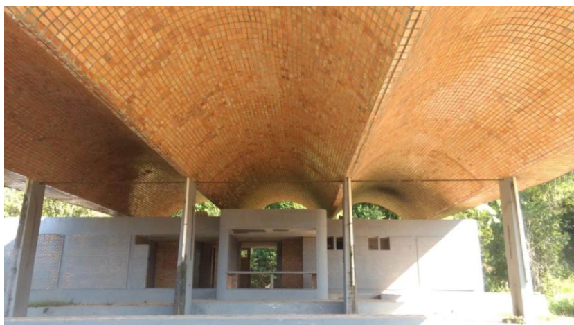
Figura 13: Posto de Controle Fiscal em Apiúna-SC. Vista interna. Fonte: Autora, 2018
