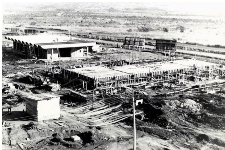
Figura 8: CEASA Goiânia: vista geral dos pavilhões em construção. Fonte: Cortesia de CEASA Goiânia
