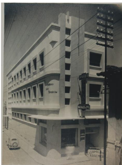
Figura 1: Edifício Santa Terezinha, Lages, Santa Catarina, 1940, projeto de Wolfgang Rau. Fonte: TEIXEIRA, 2009, p. 124.
