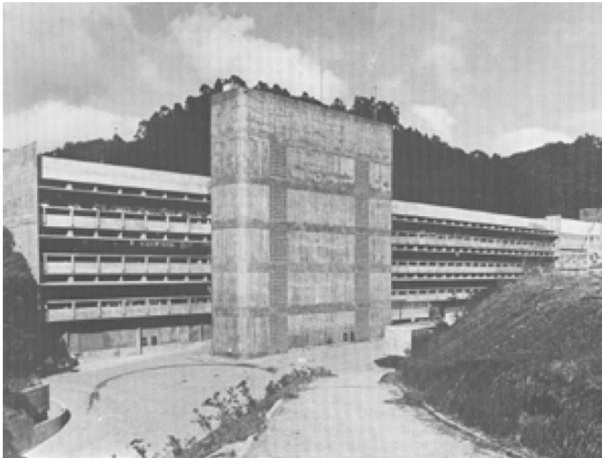
Figura 3: Hering Matriz: Edifício da Costura. Fonte: DAUFENBACH, 2005.
