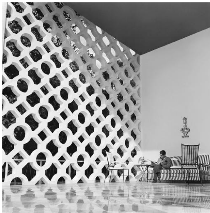
Figura 10: Vista interna da parede de cobogós, na fachada principal.
