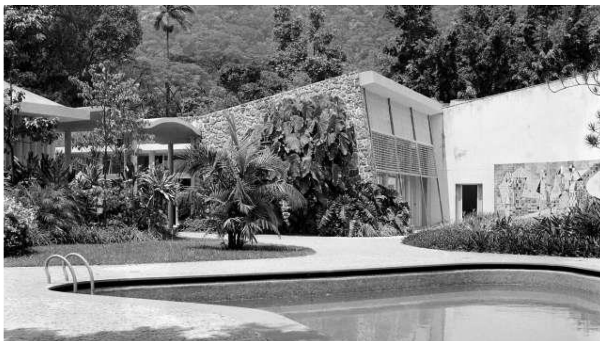
Figura 9: Vista do pátio central da Residência de W.M. Salles, mostrando a marquise ondulada, à esquerda, o painel de azulejos de Portinari, à direita, e os jardins de Burle Marx.
