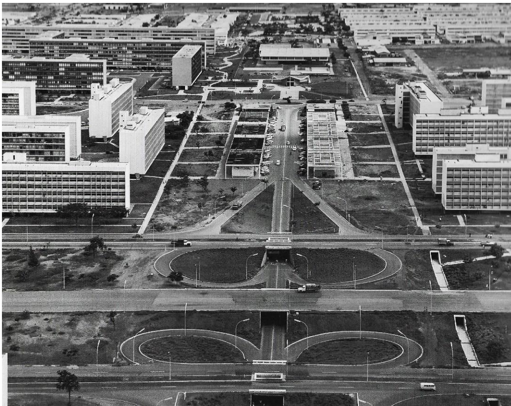
Figura 1: Vista aérea dos viadutos do Eixo Rodoviário-Residencial (“tesourinhas”), nos anos 1960. Fonte: KIM & WESELY, 2010.
