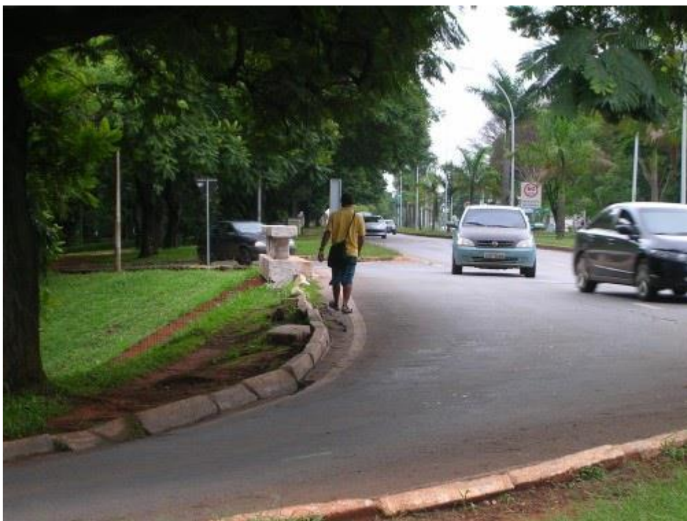
Figura 6: Pedestre circulando sobre o viaduto (“tesourinha”), em 2018. Fonte: acervo pessoal.
