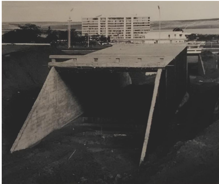
Figura 5: Viaduto do Eixo Rodoviário-Residencial (“tesourinha”) em construção, nos anos 1960, podendo ser visto o “guarda-rodas” original. Fonte: KIM & WESELY, 2010.
