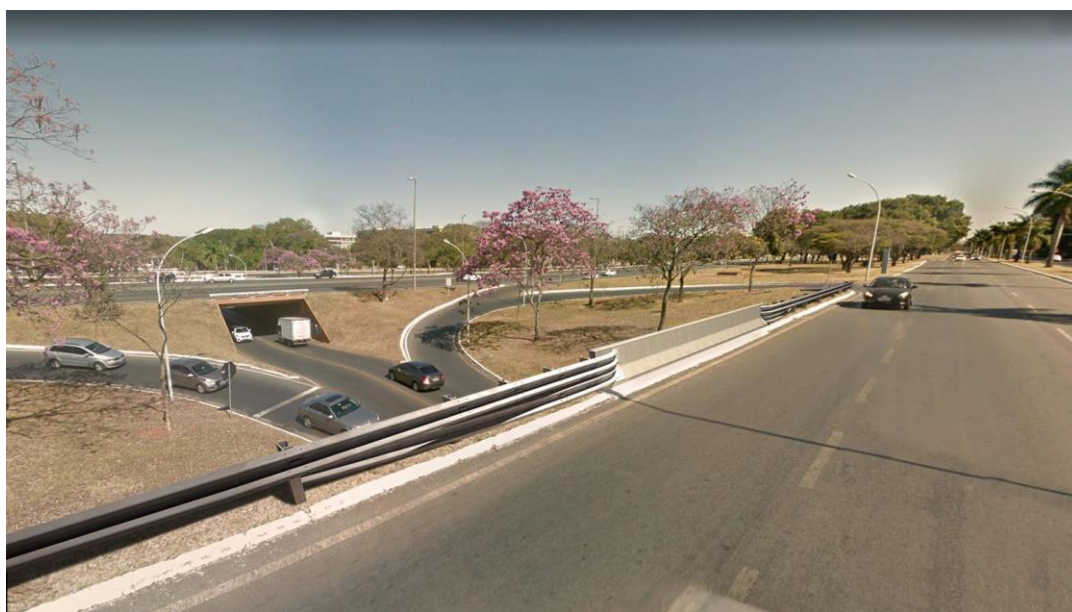
Figura 4: Simulação da proposta de substituição dos guarda-rodas dos viadutos dos “Eixinhos” por barreiras “New Jersey” e defensas metálicas.
