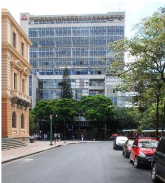
Figura 26: Edifício do IPSEMG. À esquerda, a antiga Secretaria da Fazenda e atual Memorial Minas Gerais Vale. Fonte: Foto dos autores, 2014.
