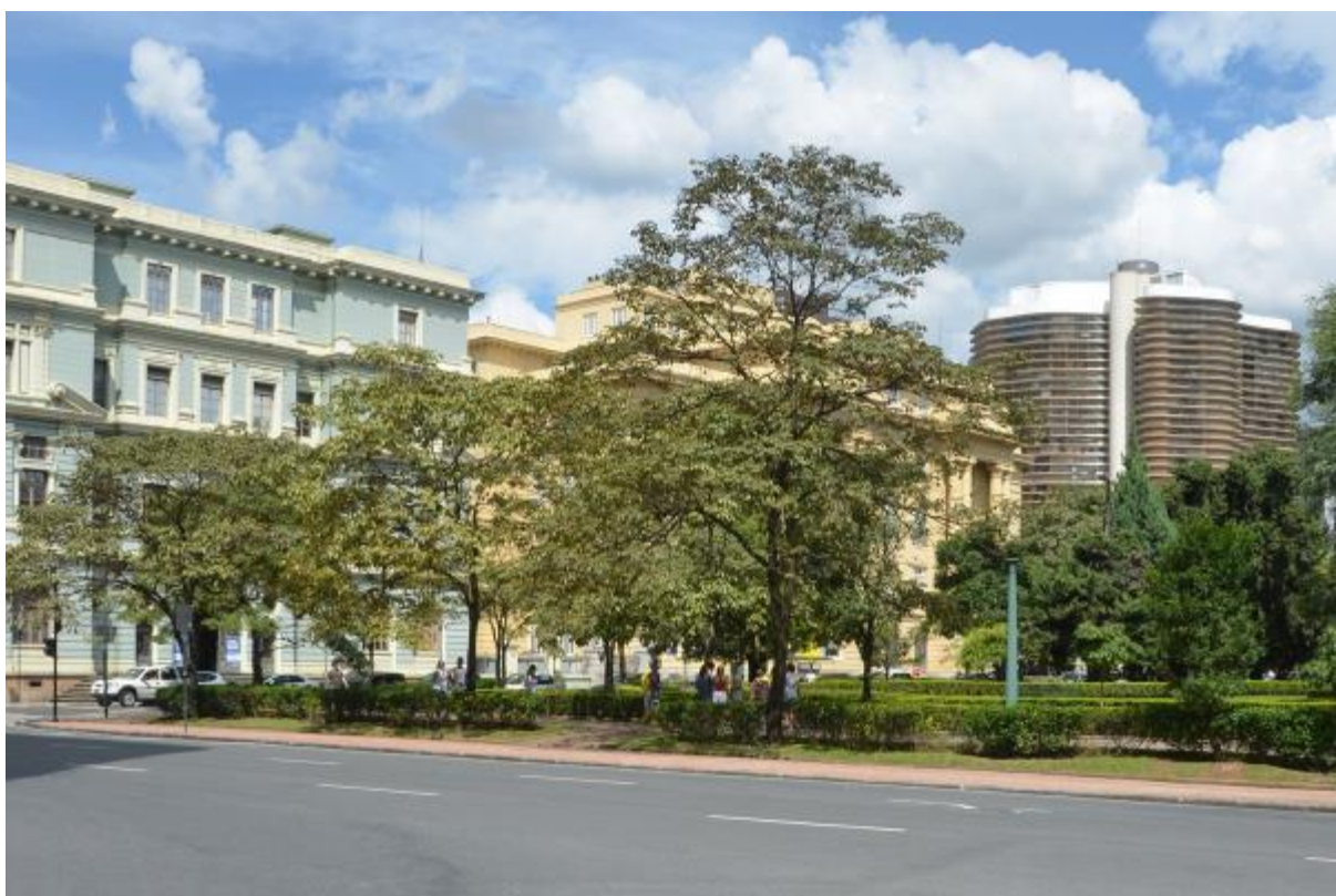
Figura 19: O Edifício Niemeyer e a preexistência historicista. Ao lado, a antiga Secretaria de Segurança Pública e a Secretaria de Agricultura (posterior Secretaria de Viação e Obras Públicas). Fotografia feita da Rua Gonçalves Dias, de frente ao Edifício Mape.
