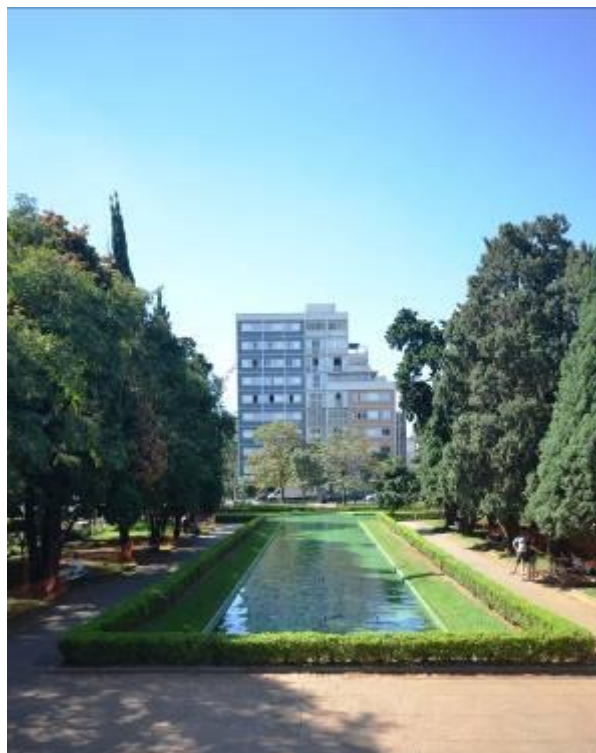
Figura 25: Edifício Mape, visto da Praça da Liberdade. Fonte: Foto dos autores, 2014.
