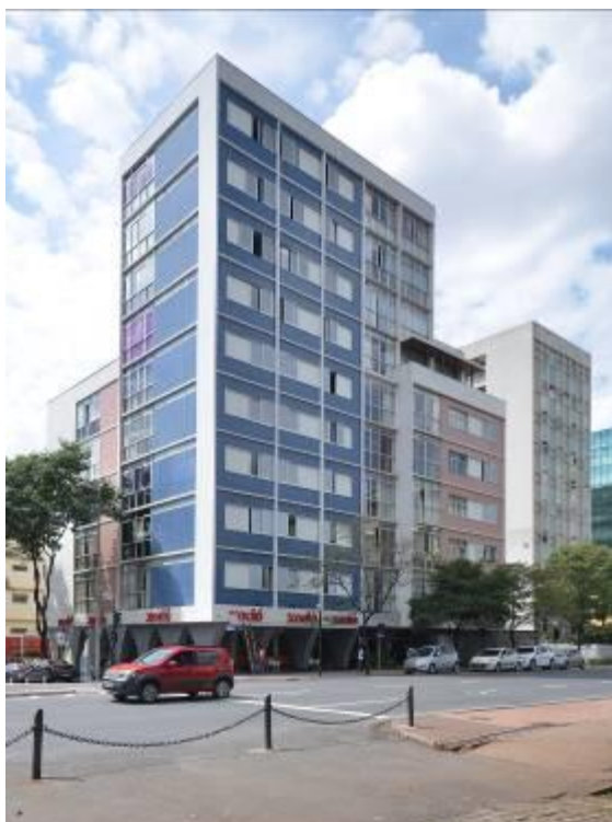
Figura 24: Edifício Mape. Fonte: Foto dos autores, 2014.
