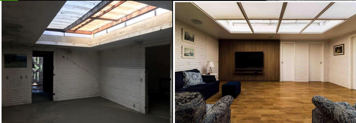
Figura 16 Zona íntima durante a reforma e com a obra finalizada.
