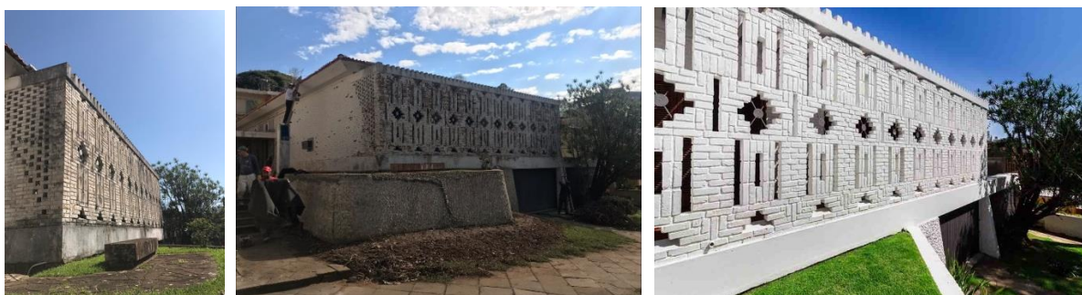
Figura 14: Conjunto de imagens da fachada principal. A primeira mostra a situação da casa antes do início da reforma, a segunda revela a fachada durante o processo de limpeza e a última já finalizada.
