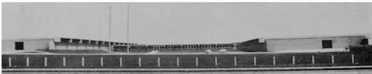
Figura 2 (da esquerda para direita, de cima para baixo): 2A : aspecto original da cobertura do pavilhão de produção (Fonte: XAVIER, 1986); 2B : volume adicionado incorporando a linguagem do edifício original (Fonte: foto da autora); 2C : novo pavilhão construído em 2018 (Fonte: foto da autora); 2D : pavilhão da produção em primeiro plano com a cobertura em laje apoiada nas grandes vigas de concreto e o volume da administração ao fundo (Fonte: foto da autora), 2E : aspecto original da fábrica nos anos 1980 (Fonte: XAVIER, 1986).
