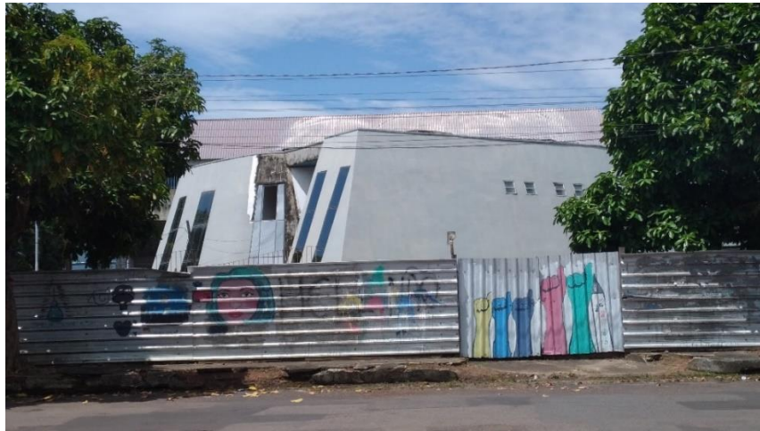
Figura 10. Atual estado de conservação do prédio da Escola de Artes Cândido Portinari
