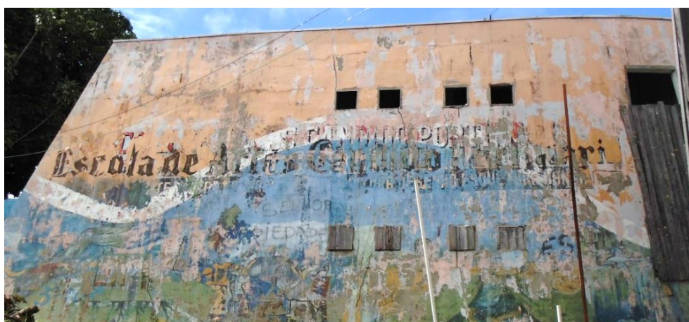
Figura 4. Vestígios das camadas de tinta da Escola de Artes Cândido Portinari Fonte: Acervo das Autoras, 2018.
