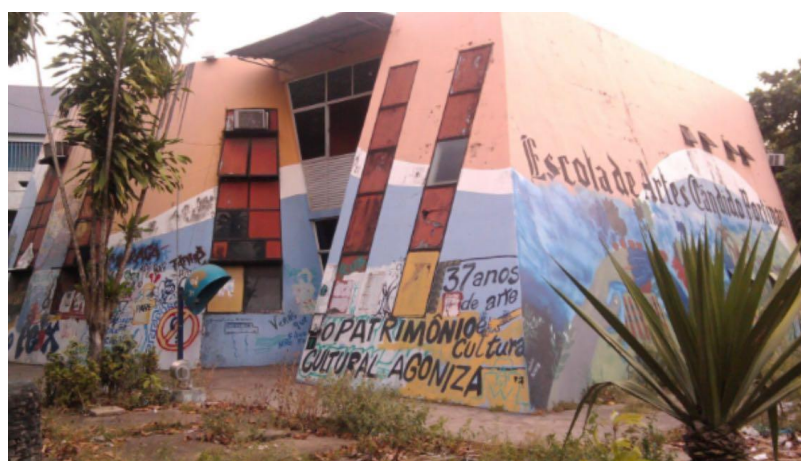
Figura 5. Área externa da Escola de Artes Cândido Portinari em 2012
