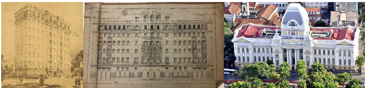
Figura 1. Obras no Centro: Hotel Central, Grande Hotel do Recife e Palácio da Justiça
