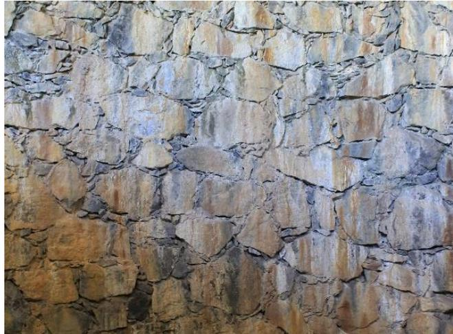
**Figura 7. Capela do Santíssimo Sacramento. Alvenaria de pedra com manchas em tons de cinza e ocre.**
