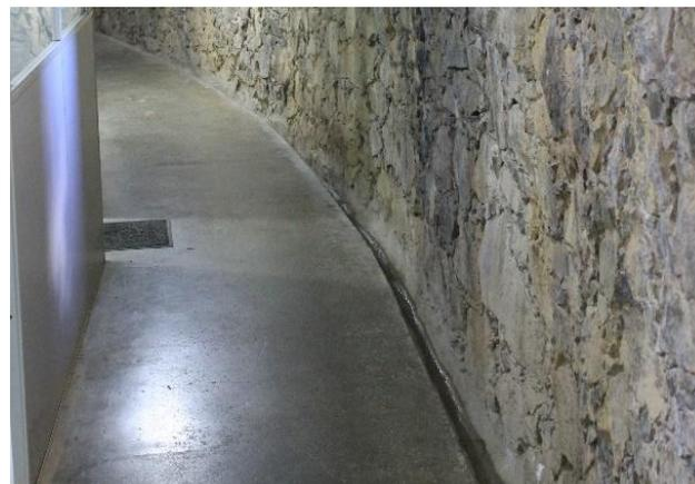
Figura 9. Corredor dos espaços de apoio. Calha perimetral, no sopé do muro de arrimo.
