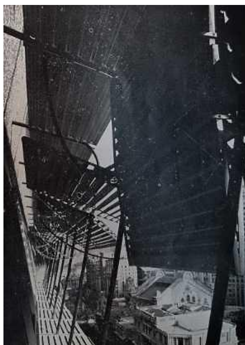
Figura 05: A vista que se tem do interior para o exterior – Av. Rio Branco (Fonte: BAC, n.8, 1956, p.39)
