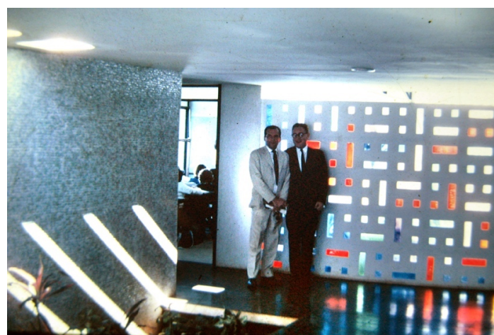
Figura 7: Acervo Wilson Reis Netto. Em raro registro a cores, podemos ver o interior do edifício com os cobogós vitrificados e seus reflexos no piso. Observar ainda a parede em pastilha (coloração em turquesa e azul celeste), teto branco, piso em ladrilho liso preto, sala de aula em piso branco ou similar. De terno claro, Wilson Reis Netto ao lado de homem não identificado.
