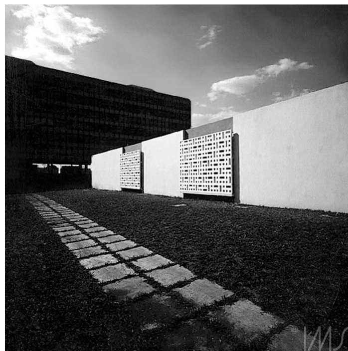
Figura 6: Escola-parque 114S, Acervo do Instituto Moreira Salles (IMS), Coleção Marcel Gautherot. Detalhe da fachada com a parede de cobogós solta da fachada.
