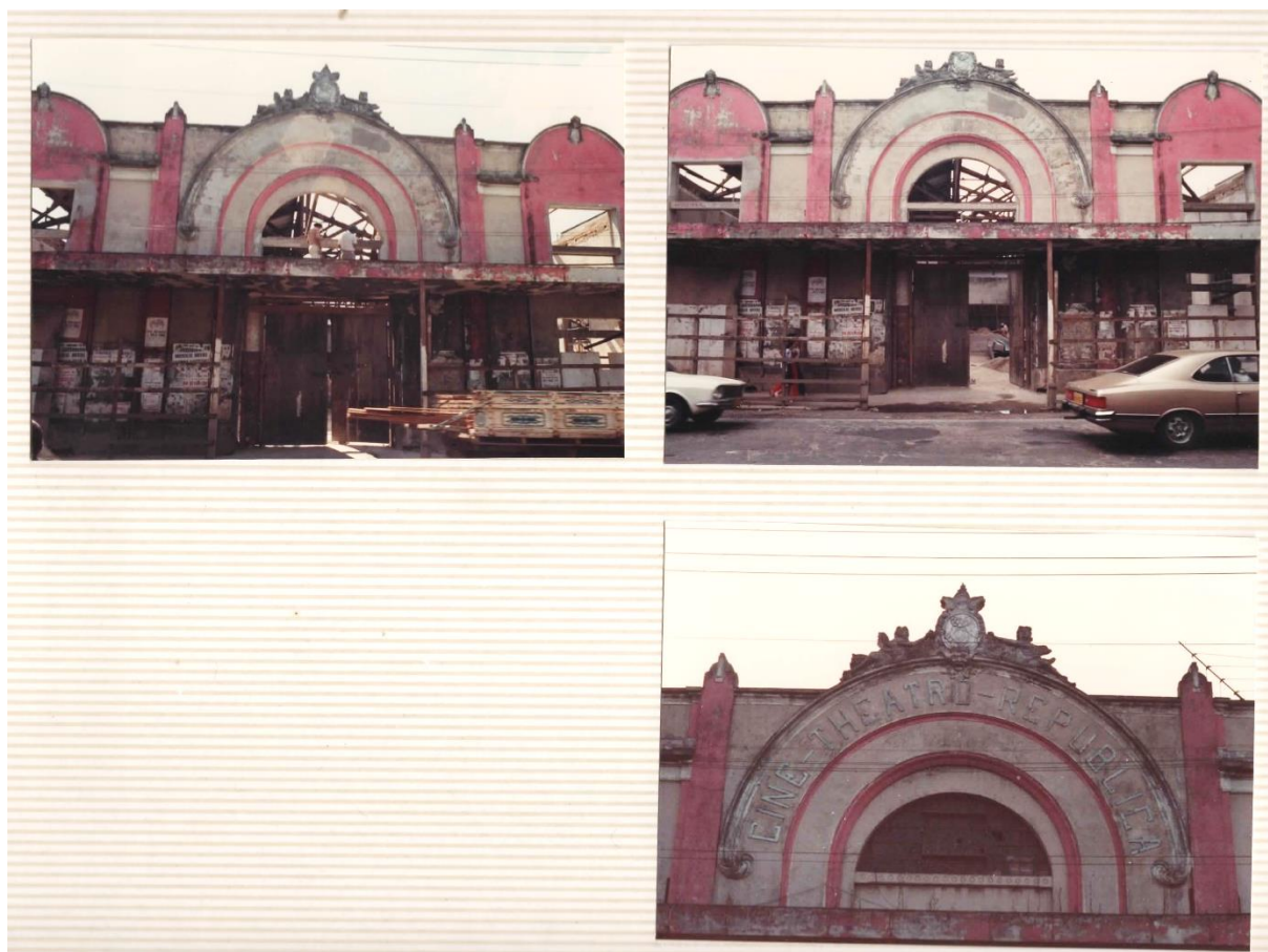
Figura 2. Fotos do cineteatro antes das obras.
