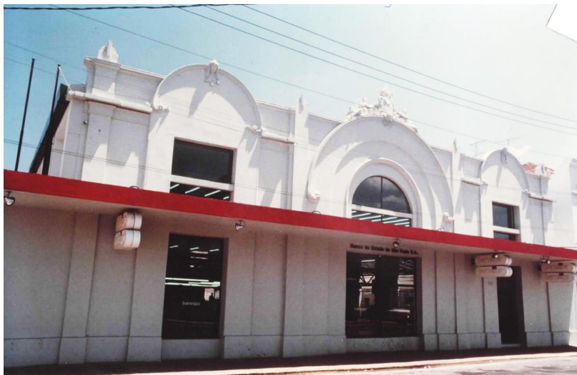
Figura 4. Fotografia da fachada do Banespa Jundiá à época.
