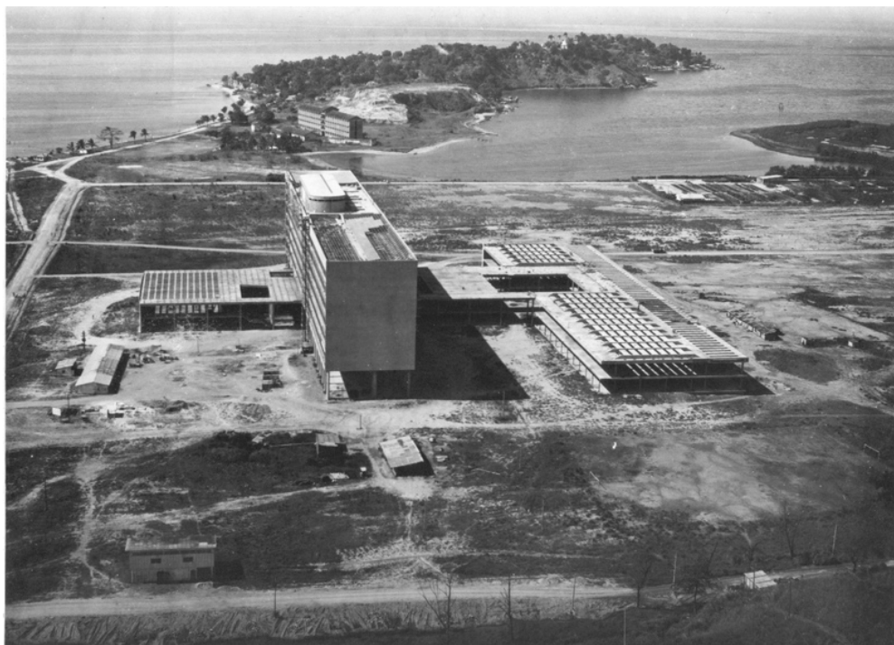
FIG. 05: Edifício da Faculdade de Arquitetura em construção (1957). Jorge Machado Moreira. Observa-se o bloco horizontal como um conjunto complexo, com a estrutura preparada para receber os sistemas de iluminação zenital.
