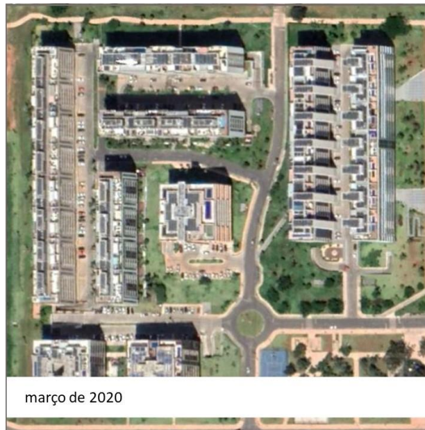
Figura 4. Vista aérea da quadra SQNW 108, localizada no Noroeste.
