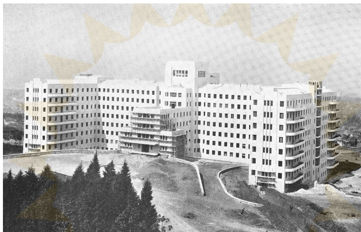
Figura 5. Edifício Central do Hospital das Clínicas em construção.
