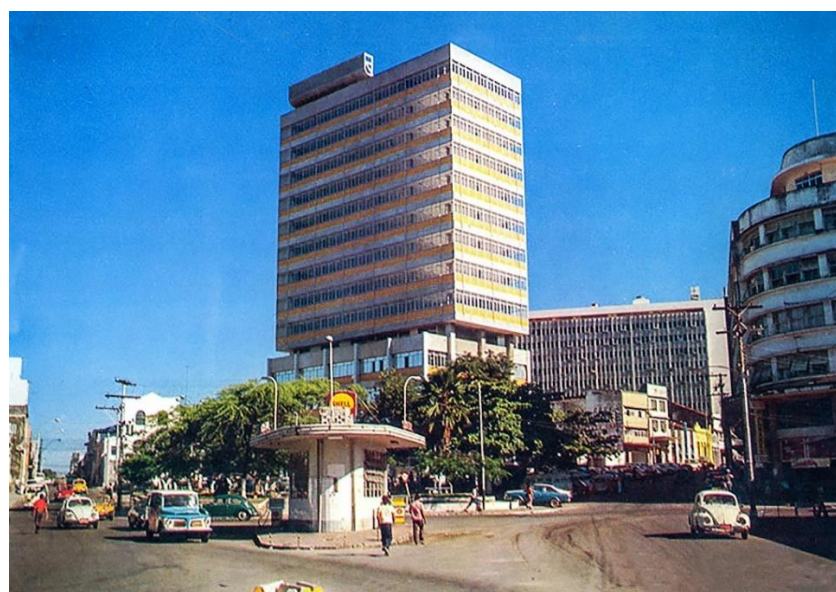
Figura 2. Edifício Palmares no final da década de 1970.
