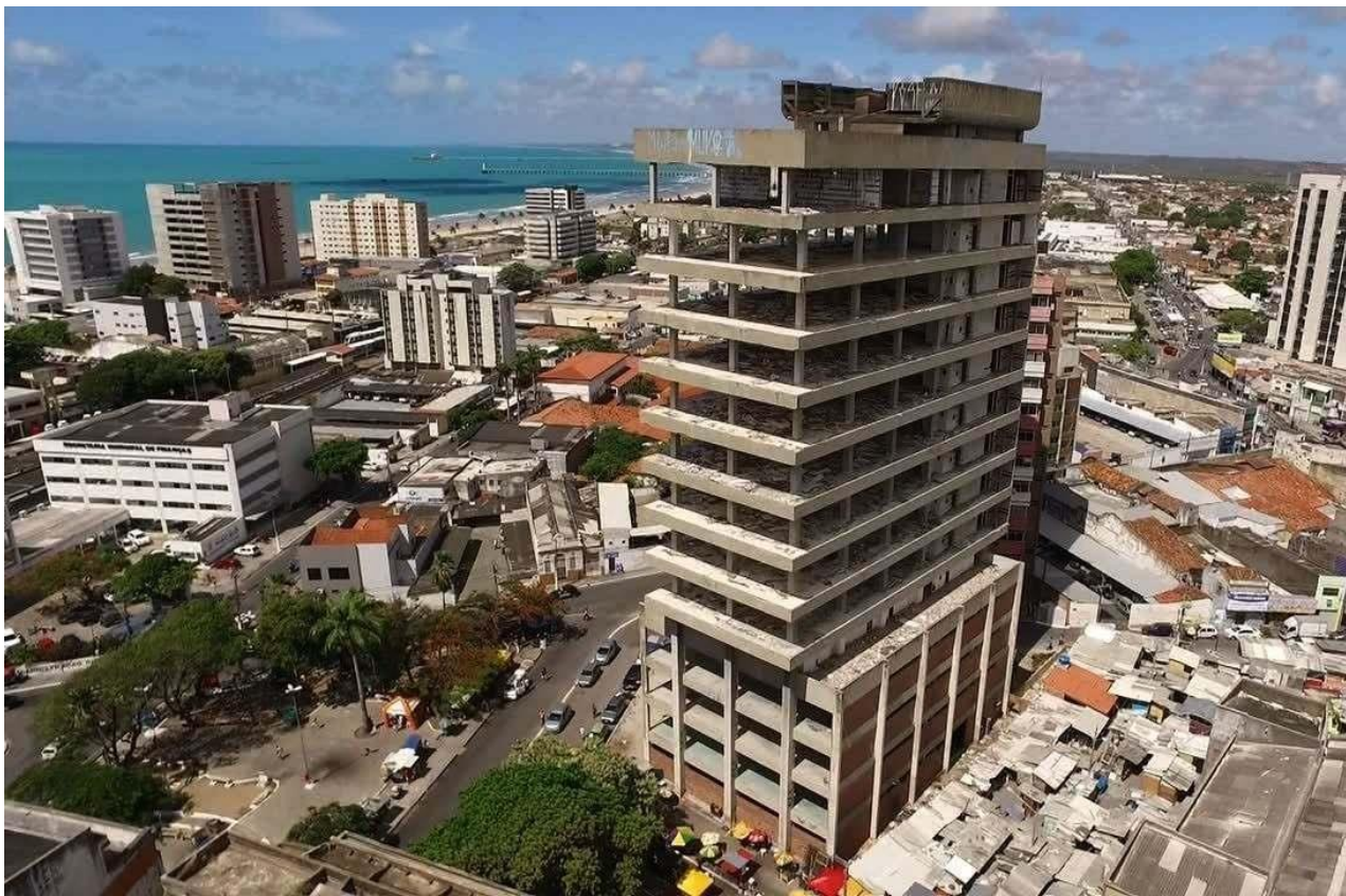
Figura 6. Edifício Palmares e entorno.
