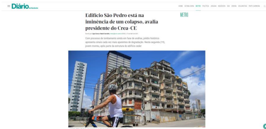
Figura 2. Recorte de matéria de jornal virtual sobre situação do Edifício São Pedro
