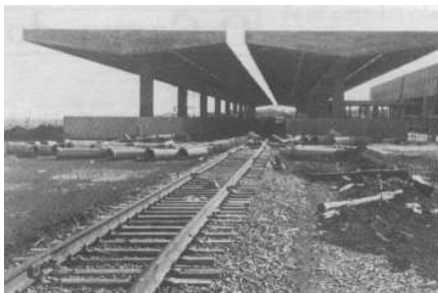
Fig. 5 - Vista do bloco secundário e das plataformas durante construção
