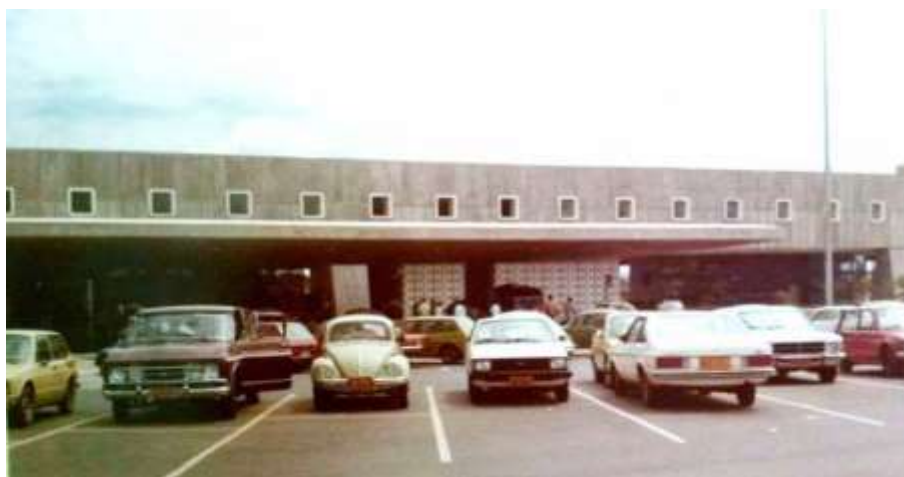
Fig. 3 - Vista da marquise do acesso principal, hoje demolida
