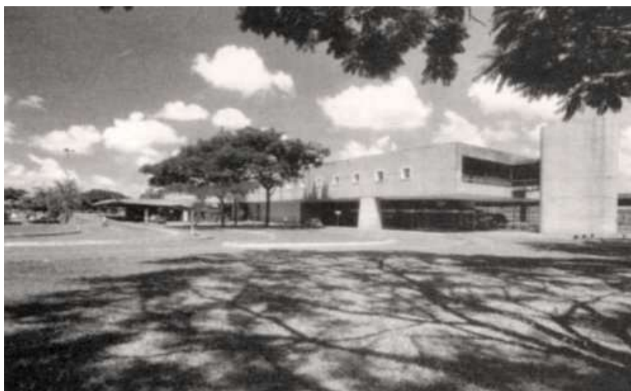
Fig. 2 - Vista do prédio da Estação Rodoferroviária de Brasília Fonte: Flávio Cavalcanti, 197?
