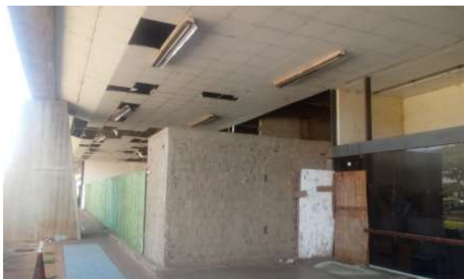
Fig. 9 - Vista de trecho da ala sul do bloco principal em obras Fonte: Magdiel Mota, 2019
