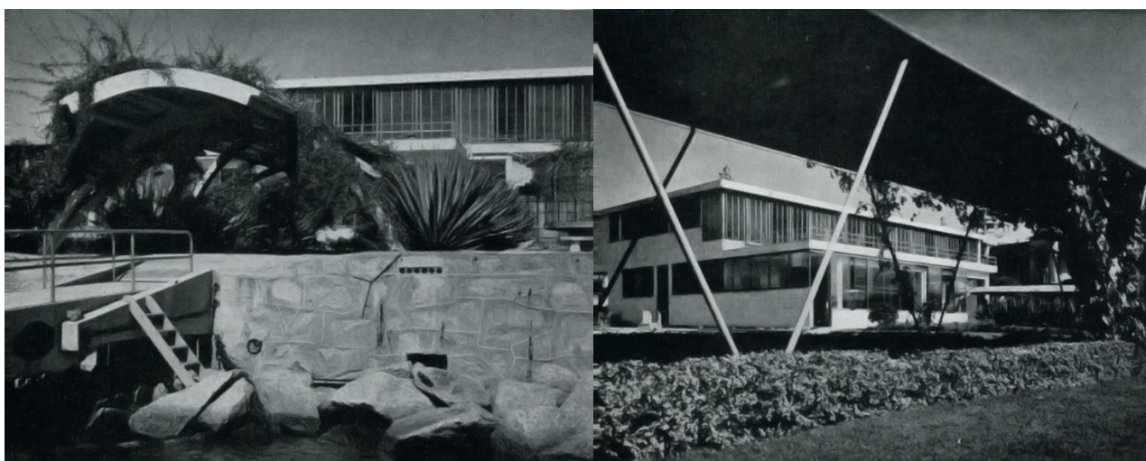
Figura 6: Vista passarela da Estação de Hidroaviões do Aeroporto Santos Dumont.
