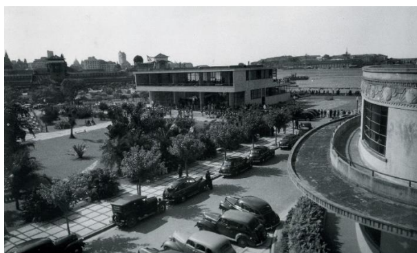
Figura 1: Vista do jardim frontal da Estação de Hidroaviões do Aeroporto Santos Dumont, desde o terminal da Panair. Fonte: https://www.archdaily.com.br/br/626074/classicos-da-arquitetura-estacao-de-hidroavioes-attilio-correa-lima/536a50fbc07a8072ce000005-classicos-da-arquitetura-estacao-de-hidroavioes-attilio-correa-lima-foto?next_project=no
